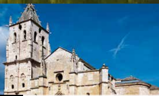
23 MaraVillas del Jarama; Patones y Torrelaguna
